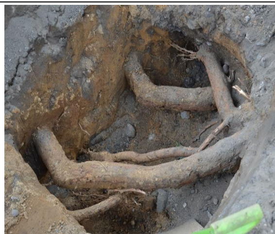
Ryc. 7. Wykopy liniowe z pozostawieniem korzeni o średnicy powyżej 1 cm (fot. E. Rosłon-Szeryńska)
